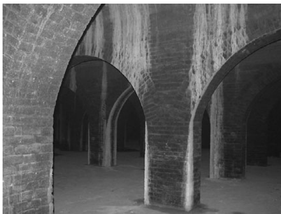
Ryc. 1. Wnętrze XIX-wiecznego, podziemnego zbiornika wodociągowego w Gdańsku-Oruni – największego zimowiska nietoperzy na Pomorzu Gdańskim (Fot. M. Ciechanowski)
